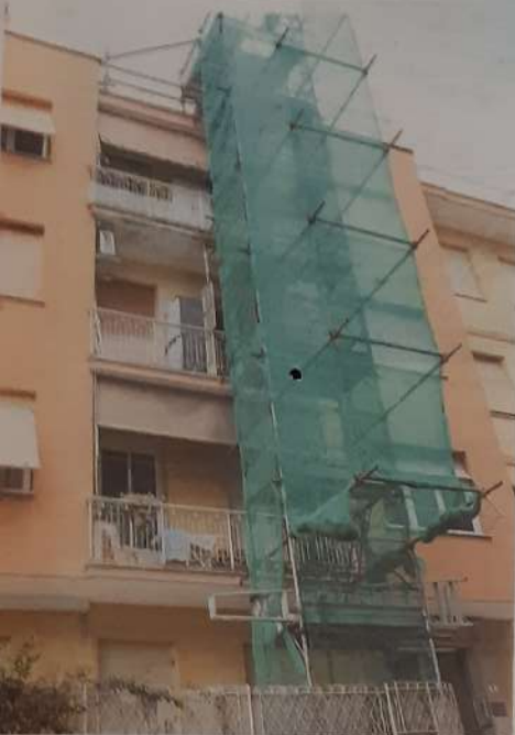
facciata di un palazzo in ristrutturazione a Rapallo
